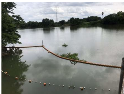
ภาพที่ 2-22 ตะแกรงป้องกันสัตว์น้ำและเจ้าหน้าที่ดูแลตลอด 24 ชั่วโมง เพื่อตรวจสอบความผิดปกติก่อนสูบน้ำที่สถานีสูบน้ำโรงไฟฟ้าราชบุรี
