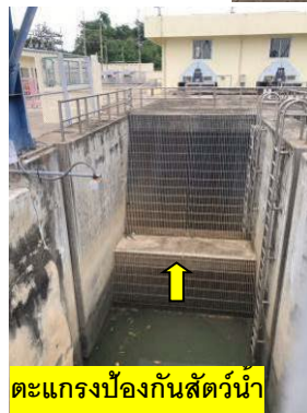
ภาพที่ 2-22 ตะแกรงป้องกันสัตว์น้ำและเจ้าหน้าที่ดูแลตลอด 24 ชั่วโมง เพื่อตรวจสอบความผิดปกติก่อนสูบน้ำที่สถานีสูบน้ำโรงไฟฟ้าราชบุรี
