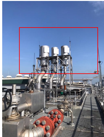
ภาพที่ 2-6 อุปกรณ์ดูดซับเสียง (Silencer)
